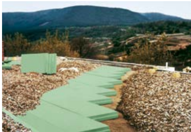
Fig. 18: Tetto rovescio risanato come struttura di tetto-plus.
