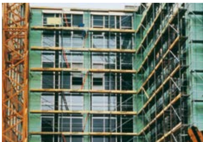
Fig. 7: Isolamento di ponti termici con Styrodur® 2000 C.
