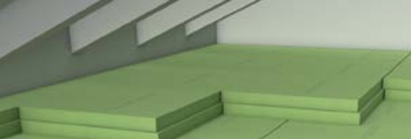
Isolamento del solaio non calpestabile
