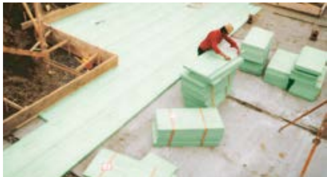
Fig. 4: Posa di lastre di Styrodur.
