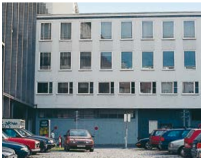
Fig. 5: Ripresa fotografica di un edificio per uffici.
