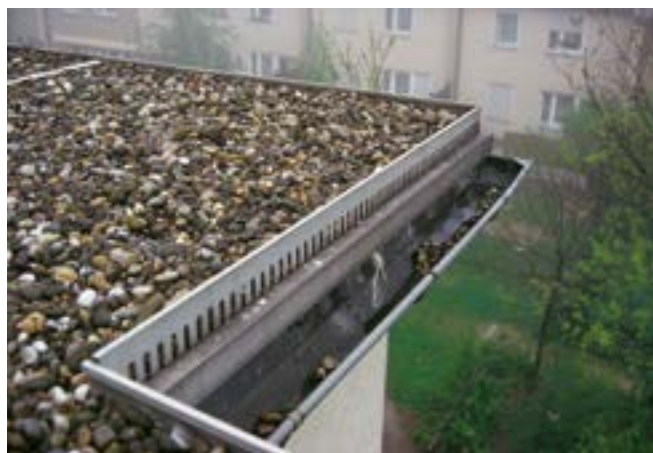
Fig. 19: Tetto a ghiaia.
