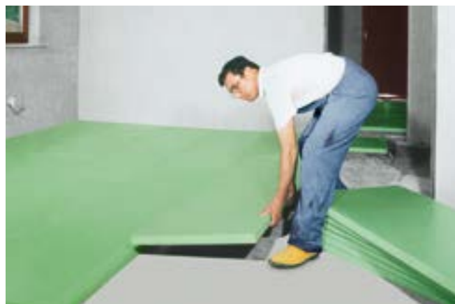
Fig. 18: Isolamento del pavimento della cantina.
