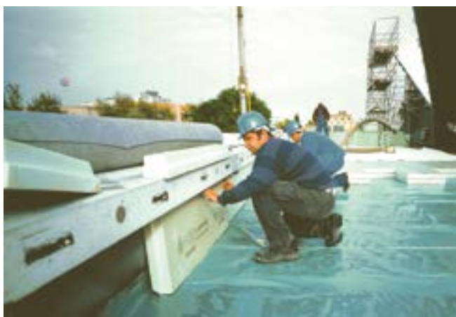
Fig. 15: Isolamento della veletta con Styrodur®.
