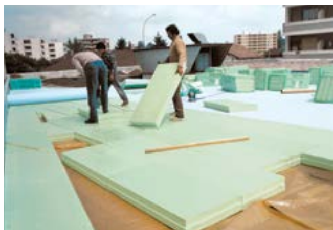
Fig. 14: Posa di Styrodur® per tetto-duo.
