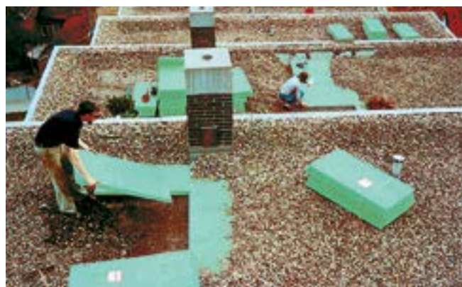
Fig. 2: Styrodur®, grazie alla sua resistenza alla compressione e alla ridotta conduttività termica, è particolarmente indicato per strutture di tetti rovesci.
