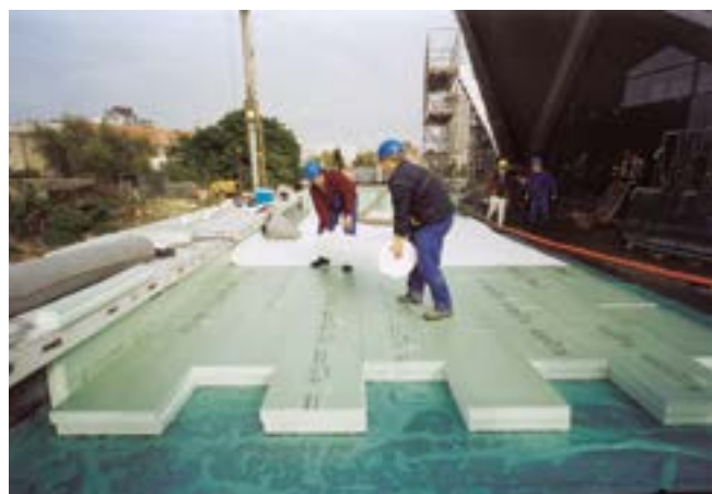
Fig. 16: Posa di Styrodur® sopra all'impermeabilizzazione del tetto.
