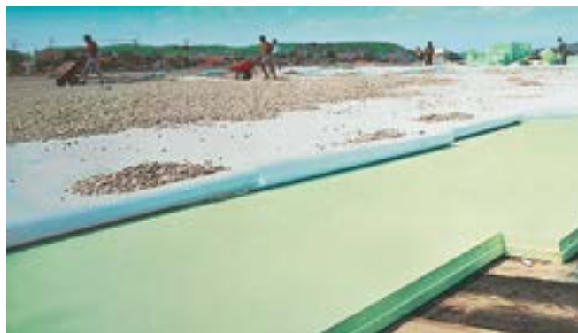
Fig. 11: Tetto rovescio con riporto di ghiaia.
