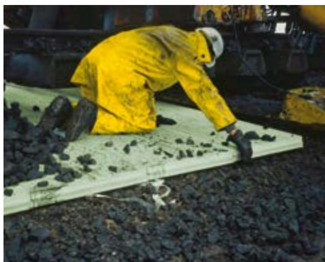
Fig. 9: Posa di Styrodur® nella massicciata ferroviaria.
