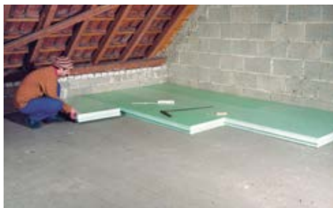
Fig. 2: Isolamento del sottotetto con Styrodur.
