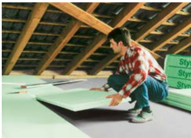
Fig. 10: Isolamento di un sottotetto con Styrodur®.
