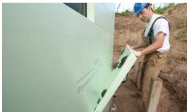
Fig. 5: Incollaggio a punti del secondo strato Lastre di Styrodur® con battentatura e giunti sfalsati.
