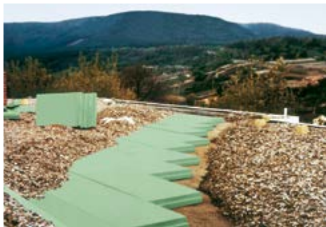
Fig. 18: Tetto rovescio risanato come struttura di tetto-plus.
