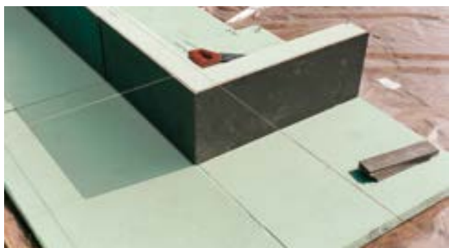
Fig. 3: Isolamento di una piastra di fondazione con Styrodur®.
