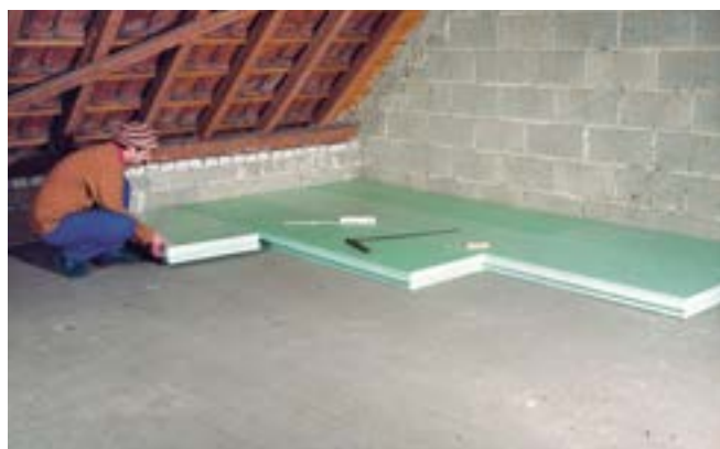
Fig. 2: Isolamento del sottotetto con Styrodur.
