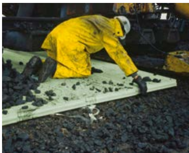
Fig. 9: Posa di Styrodur® nella massicciata ferroviaria.
