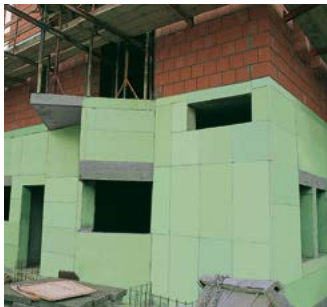
Fig. 25: Isolamento di un pianterreno con lastre di Styrodur® 2000 C.
