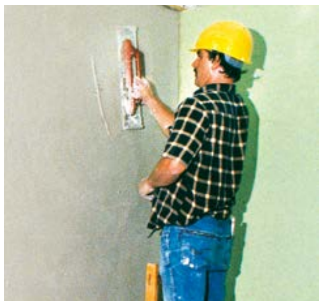
Fig. 31: Stesura del secondo strato di intonaco, spessore di circa 5 mm. L'applicazione dell'intonaco avviene fresco su fresco.
