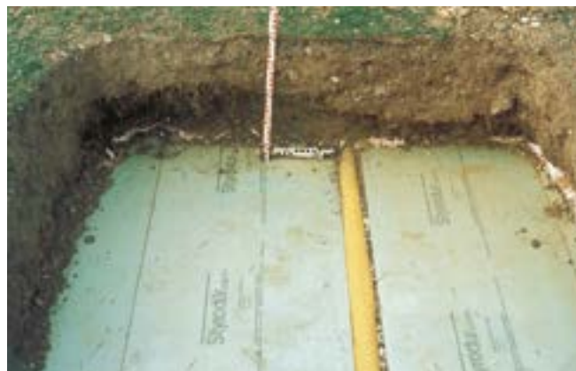
Fig. 6: Prelievo di campioni da un tetto rovescio verde di dieci anni.
