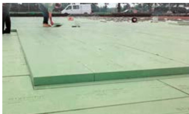
Fig. 8: Posa a vari strati di lastre di Styrodur® sotto la soletta.
