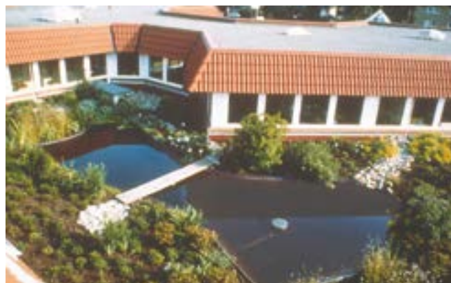
Fig. 24: Tetto a terrazza rinverdito e calpestabile con irrigazione a raccolta in stagni artificiali su una struttura di tetto rovescio con strato drenante di ghiaia su tutta la superficie.
