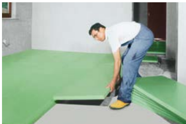
Fig. 18: Isolamento del pavimento della cantina.
