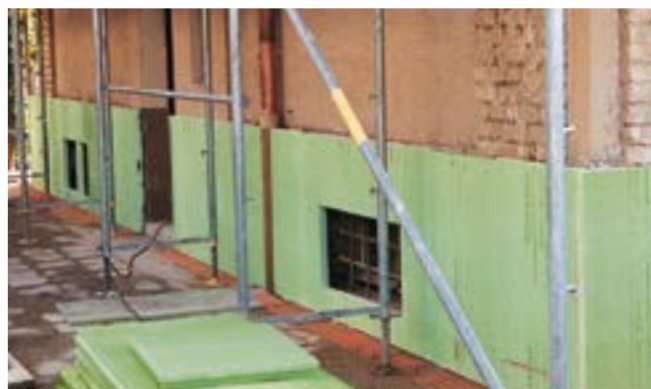
Fig. 17: Successivo isolamento dello zoccolo con Styrodur® 2000 C.
