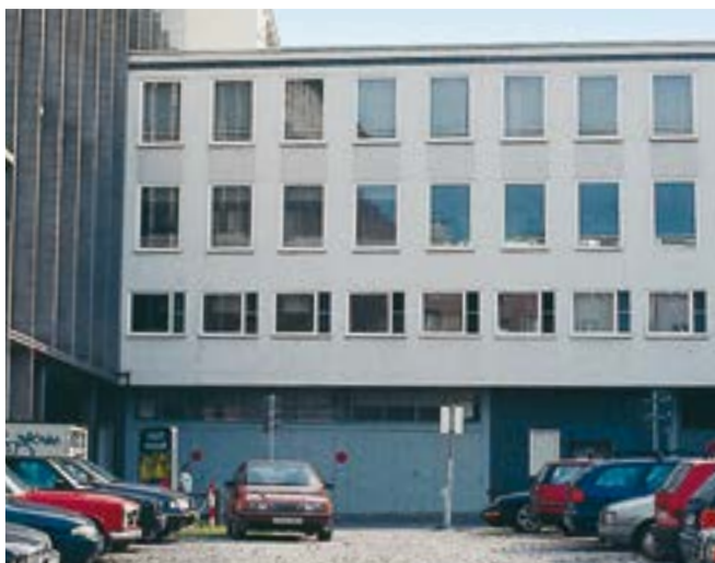
Fig. 5: Ripresa fotografica di un edificio per uffici.
