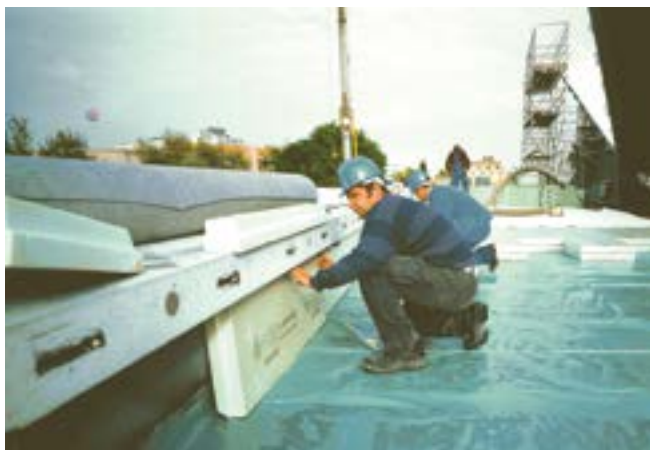
Fig. 15: Isolamento della veletta con Styrodur®.
