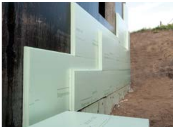
Fig. 3: Realizzazione di un isolamento perimetrale a due strati di Styrodur® fino a riempimento dello scavo di fondazione.
