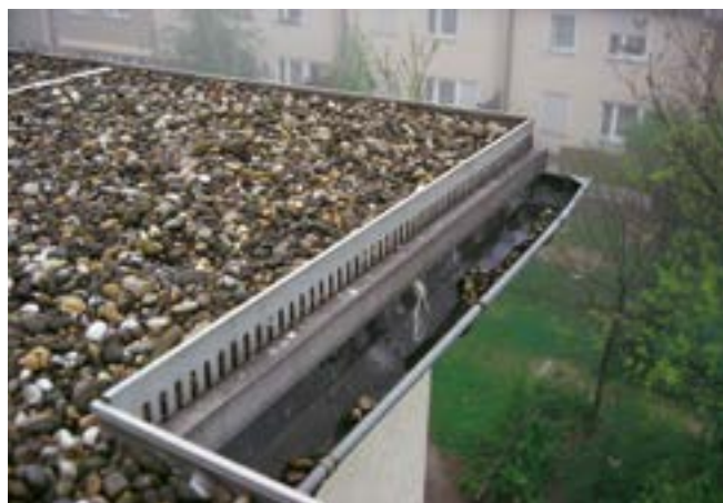
Fig. 19: Tetto a ghiaia.
