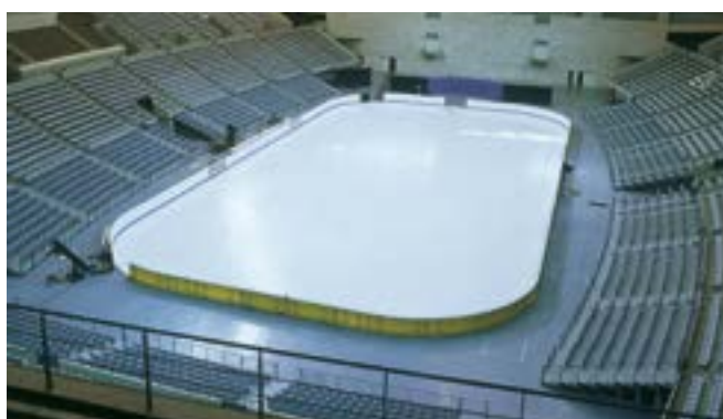
Fig. 16: Styrodur® posato sotto a una pista di ghiaccio.
