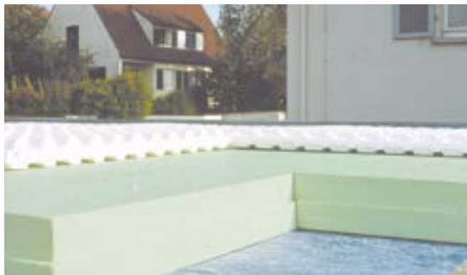
Fig. 23: Lastre preformate di EPS per la ritenzione dell'acqua e il drenaggio di un tetto rovescio verde con Styrodur®.
