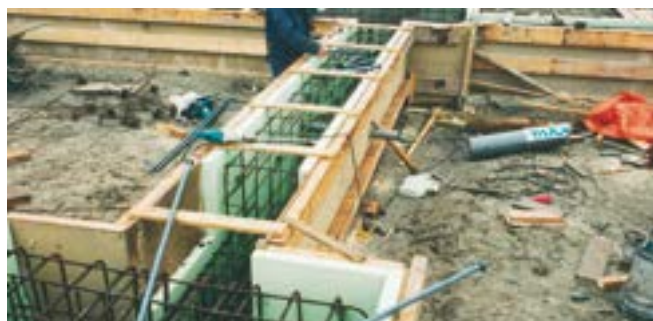
Fig. 27: Cassaforma con Styrodur®.
