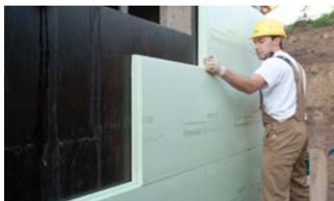
Fig. 4: La posa allineata delle lastre di Styrodur® garantisce un isolamento perimetrale senza ponti termici.
