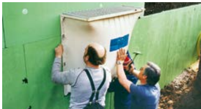
Fig. 24: Montaggio del lucernario nell'isolamento perimetrale.
