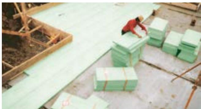
Fig. 4: Posa di lastre di Styrodur.
