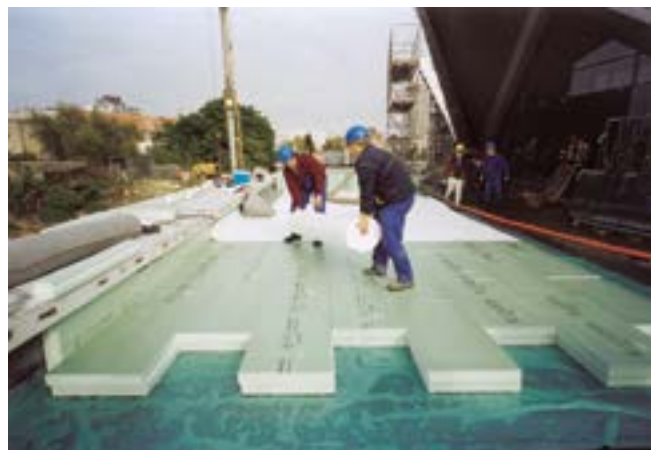
Fig. 16: Posa di Styrodur® sopra all'impermeabilizzazione del tetto.
