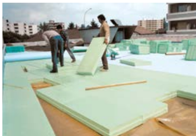
Fig. 14: Posa di Styrodur® per tetto-duo.
