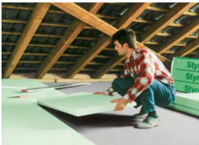
Fig. 10: Isolamento di un sottotetto con Styrodur®.
