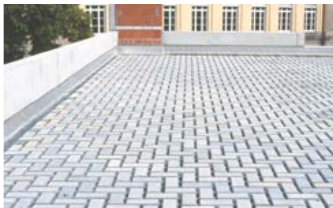
Fig. 49: Pavimentazione autobloccante in calcestruzzo su Styrodur®.
