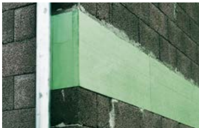
Fig. 2: Isolamento termico nel perimetro del solaio con Styrodur® 2000 C.
