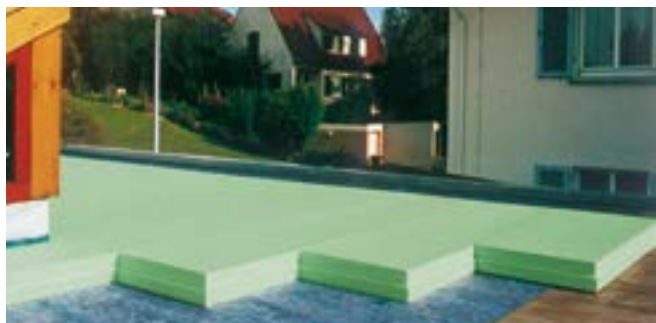
Fig. 26: Posa di lastre di Styrodur® sotto a rinverdimento estensivo del tetto.
