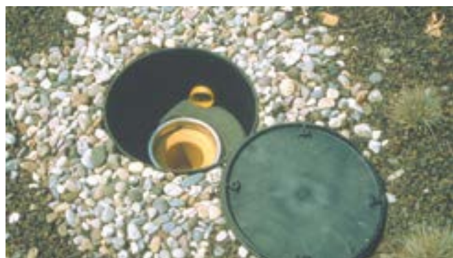
Fig. 10: Bocchetta di scarico del tetto.
