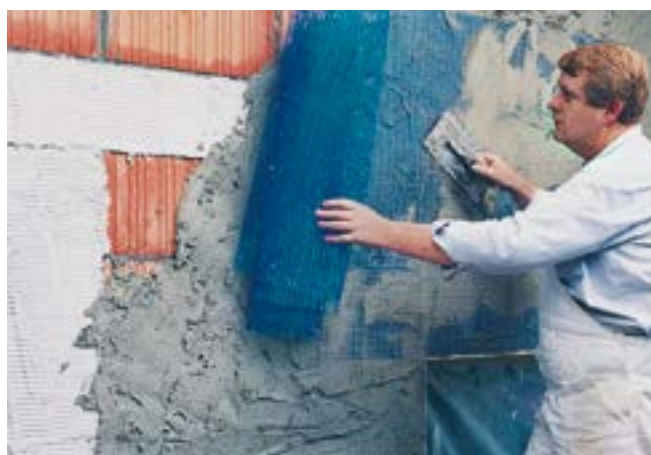
Fig. 22: Applicazione dell'intonaco di fondo e posa dell'armatura con rete in fibra di vetro sugli elementi strutturali in calcestruzzo isolati.
