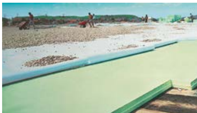
Fig. 11: Tetto rovescio con riporto di ghiaia.
