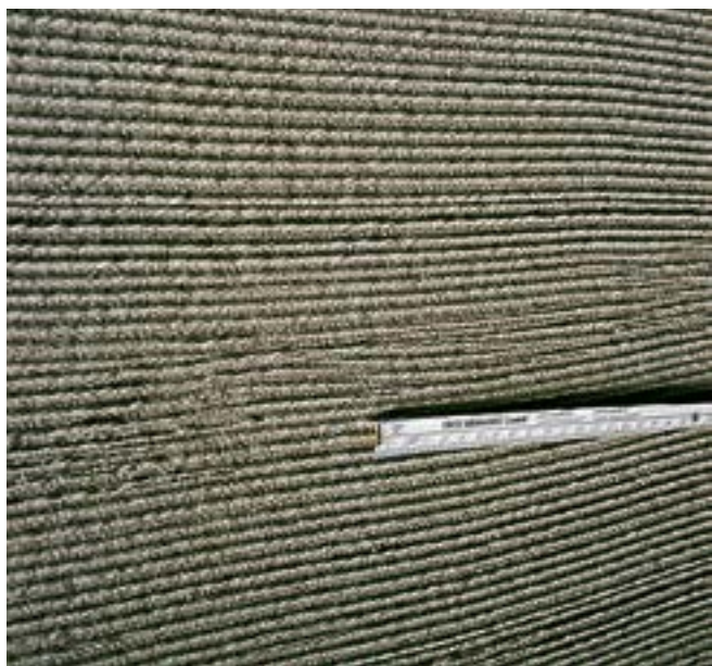
Fig. 24: Stesura orizzontale dello strato adesivo sull'isolamento con Styrodur® 2000 C.
