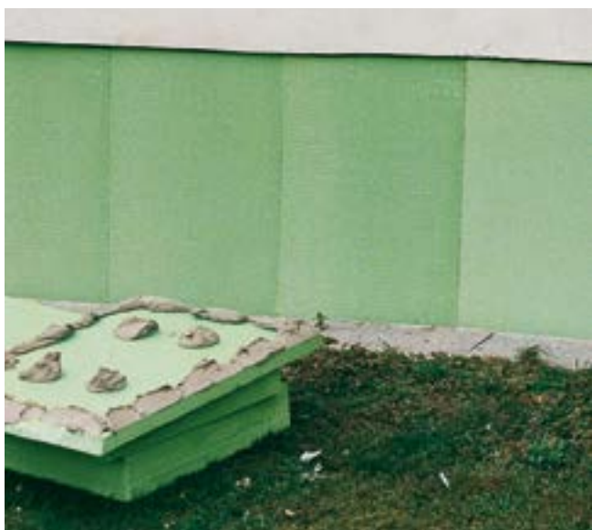
Fig. 28: Risanamento di una vecchia costruzione; incollaggio di lastre di Styrodur® 2000 C con procedura di giunzione a punti sul bordo.
